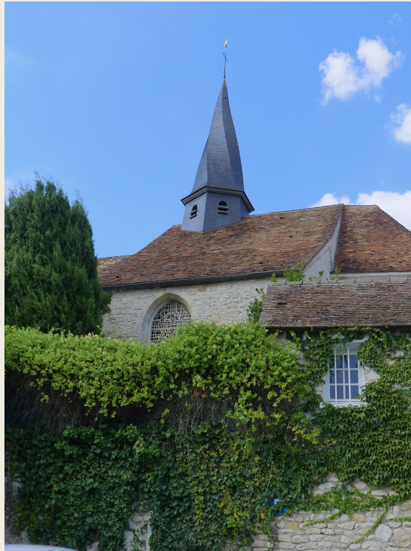
Boulancourt: clocher tors récent ...en lamellé collé
